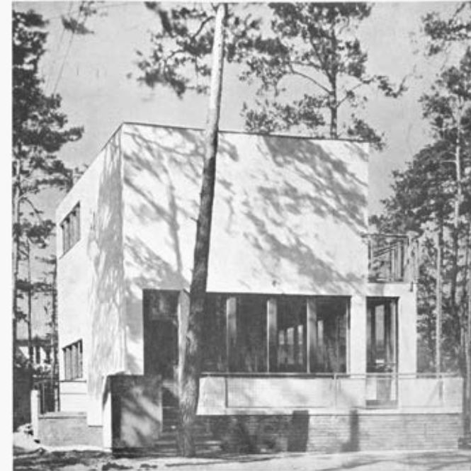
ARCH. HELENA SYRKUS (SARP), ARCH. SZYMON SYRKUS (SARP) Dom jednorodzinny. Maison pour une famille. One-family House. Einfamilienhaus. Casa per una famiglia. Skolimów
