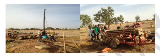
Photo 1, pose des tuyaux. Photo 2 Premier sondage entre l'eau et la surface est 39,4 mètres les 21 mètres est de l'eau.
